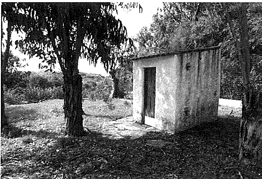
Figura 7 - edifício Casa do Furo a remover (n.º 7)
