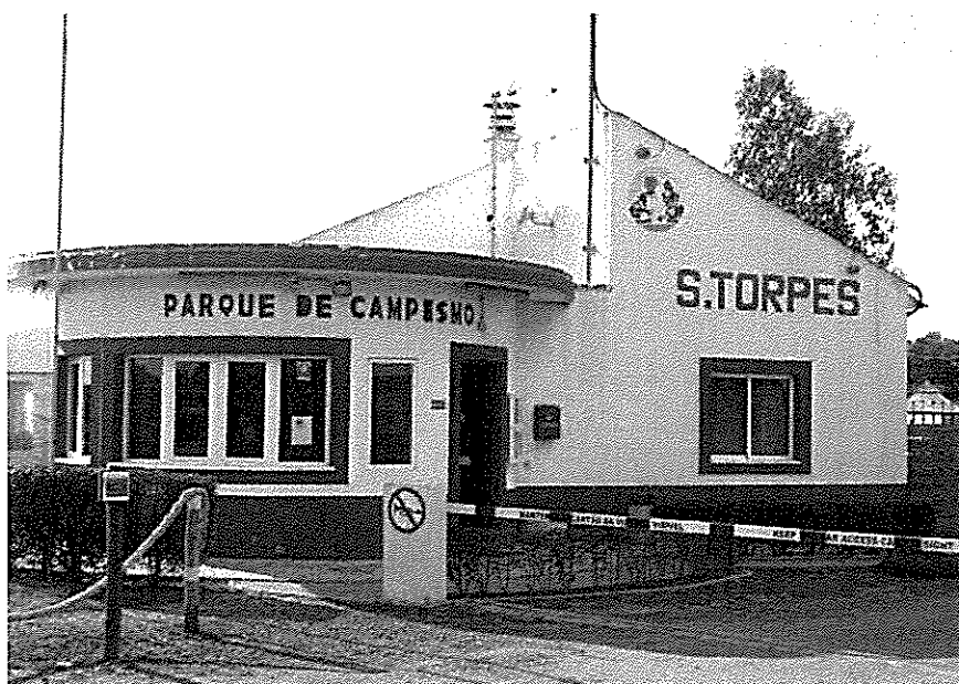
Figura 4 - edifício Receção a remodelar (n.º 3)
